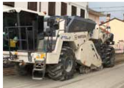
I poderosi mezzi utilizzati per il rifacimento del manto stradale di via Visini.
