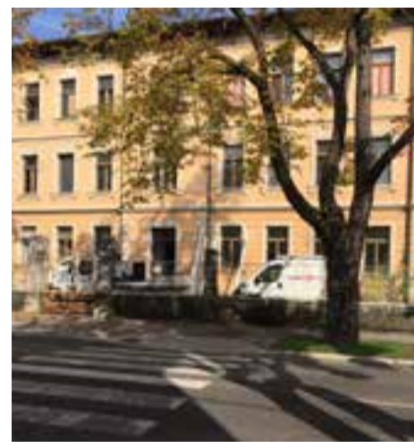
Ripresi in autunno i lavori all'ex scuola elementare.
