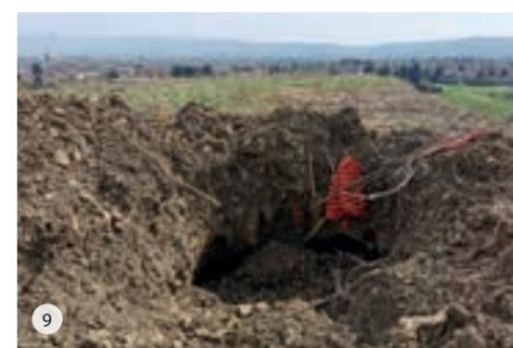
Fig. 8: pozzetto d'accesso all'opera della Guerra Fredda posta a ridosso di quota 110. Fig. 9: sprofondamento della volta della caverna ricovero scavata alla sommità della dorsale di quota 104.
