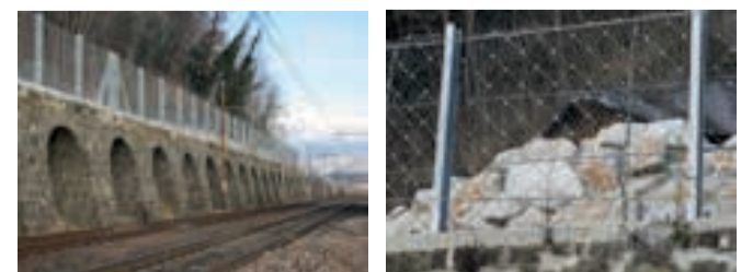
Fig. 3-4 - Muro di contenimento e barriera paramassi lungo la linea ferroviaria Udine-Trieste.
