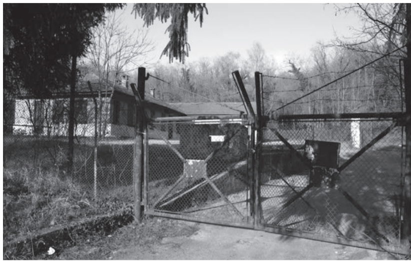
Anche la polveriera è ormai ridotta a struttura fatiscente
