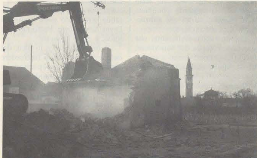
17 gennaio 1986, inizia la demolizione.
