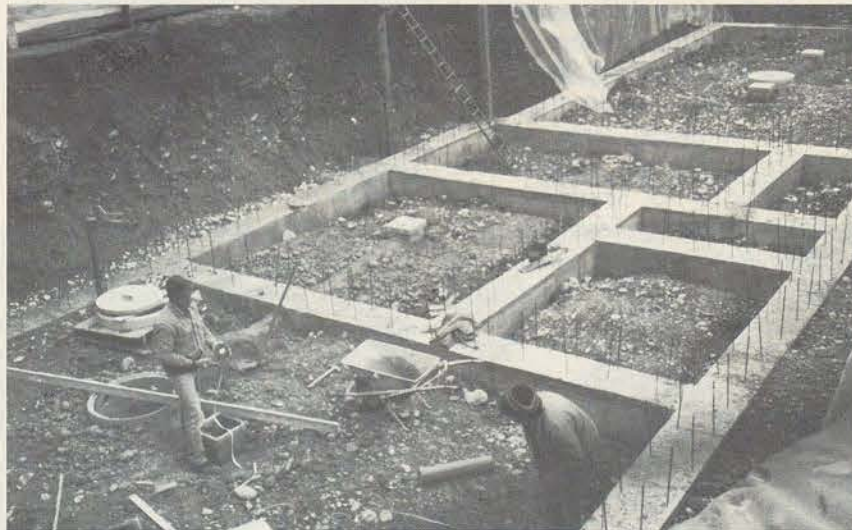
Febbraio 1986, veduta delle fondazioni della nuova costruzione.
