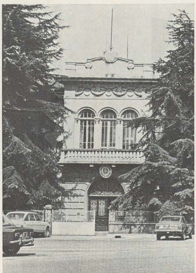
L'attuale sede della scuola media «Leopoldo Perco» nel palazzo dell'ex Municipio.
